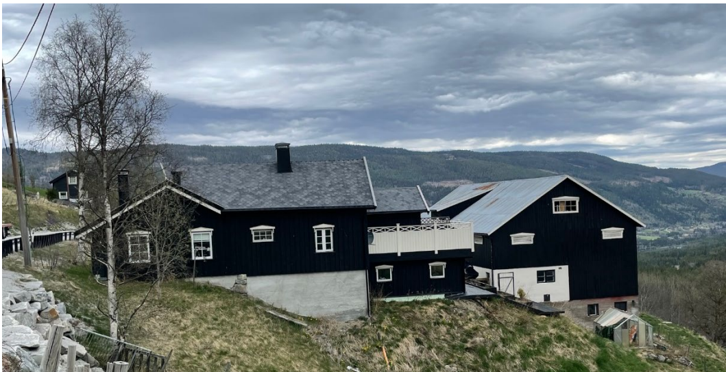
Figur 4-8. Bilde fra befaring viser at bygget er revet (Rambøll, 2022)
